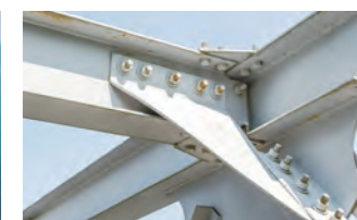
橋梁の設置、点検
