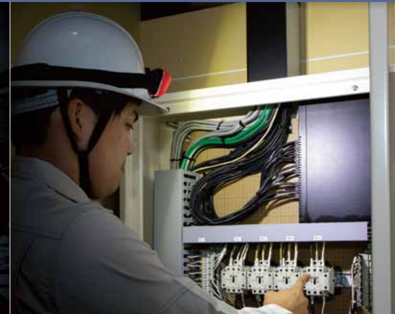
配電盤の点検に
