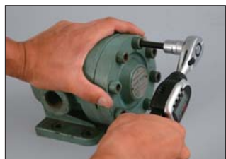
ポンプのボルト組付
