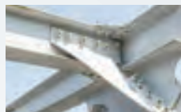
橋梁の設置、点検
