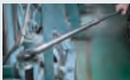
工場設備の点検
