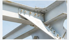
橋梁の設置、点検
